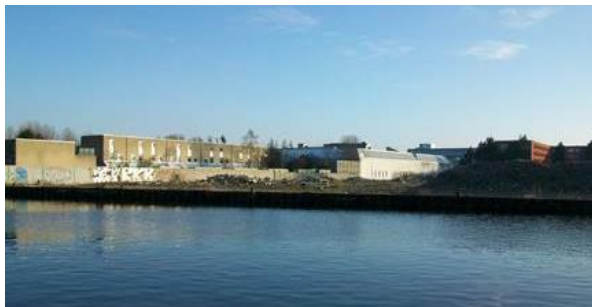
Fig. 3.3: Huidige situatie Rotterdamseweg ter hoogte van nr. 202
