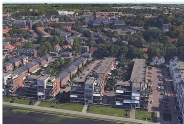
Fig. 3.2: Huidige situatie Rotterdamseweg t.h.v. nr. 150
